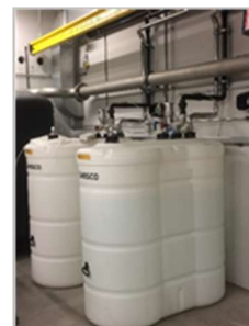
Harnstoff-Tankanlage
