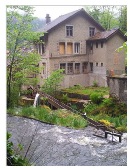
Nagelschmiede vor Sanierung
