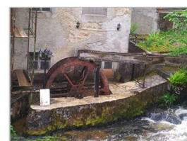
Wasserrad mit Zulaufkanal
