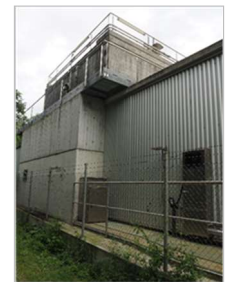
Vor der Realisierung
